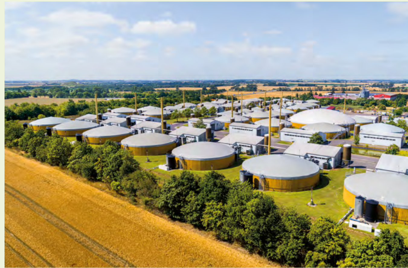
NAWARO BioEnergy Park Klarsee GmbH in Krackow
