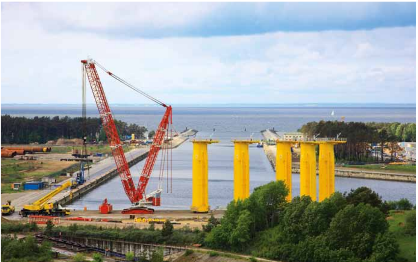
Industrieafen Lubmin – ein Umschlagafen für großvolumige und schwere Güter
