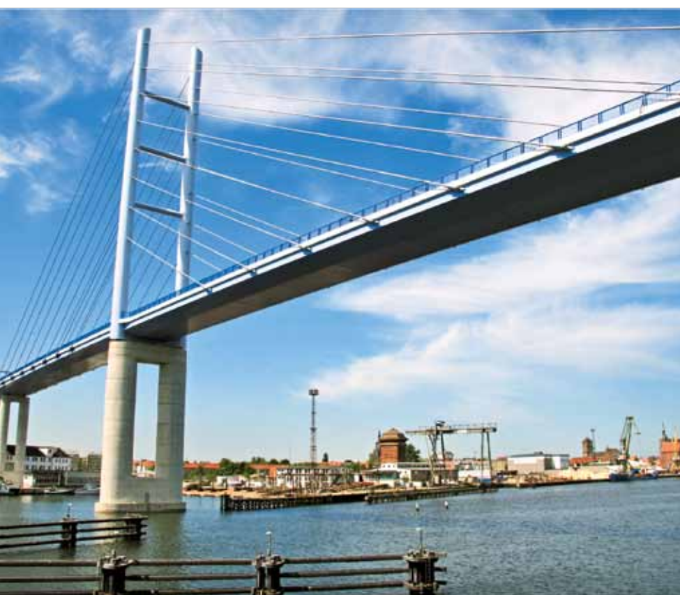
Vorpommern schafft Verbindungen – die neue Rügenbrücke zwischen Stralsund und der größten Insel Deutschlands
